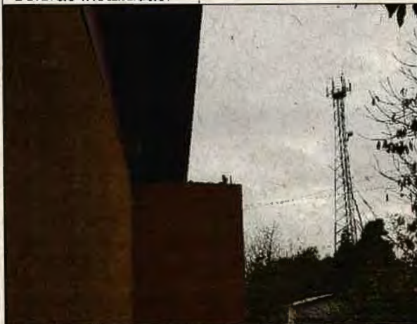
Foto N°23: 16 de mayo de 2018. Muro casetas sanitarias.
