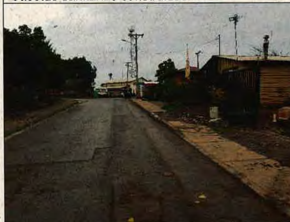
Foto N°47: 16 de mayo de 2018 Corte y reposición de pavimentos.
