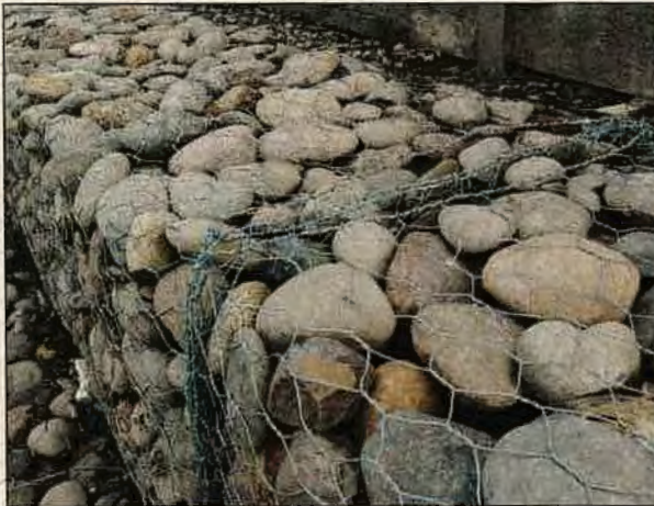
Foto N°19: 10 de mayo de 2018. Gaviones recinto PTAS.
