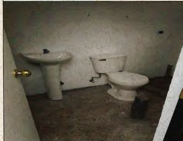
Foto N°11: 16 de mayo de 2018. Interior casetas sanitarias.
