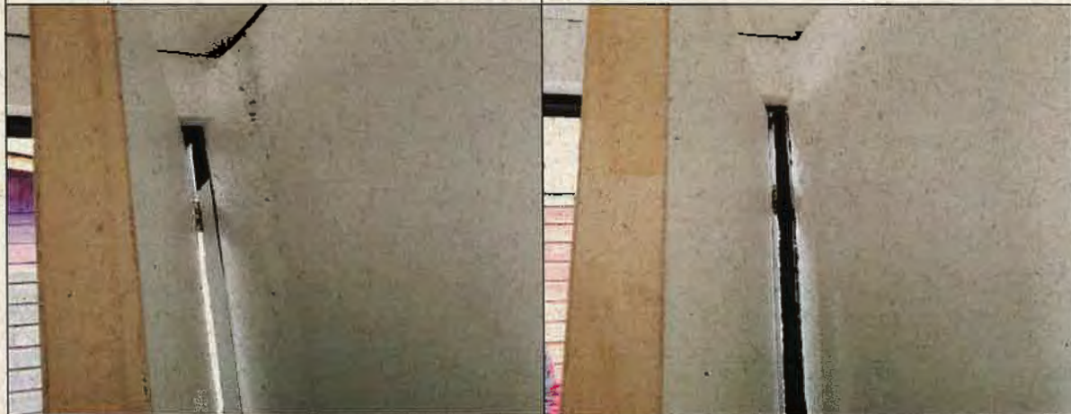
Foto N°33: 16 de mayo de 2018. Interior casetas sanitarias.
