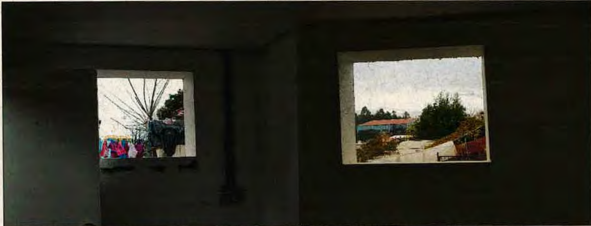
Foto N°25: 16 de mayo de 2018. Interior casetas sanitarias.
