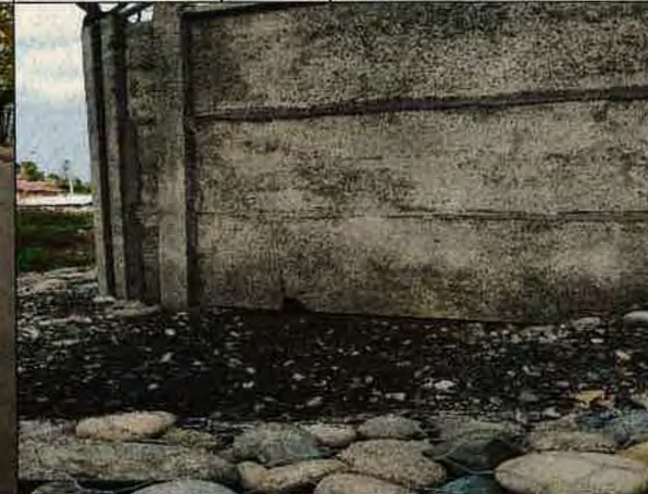
Foto N°18: 10 de mayo de 2018. Cierre recinto PTAS.
