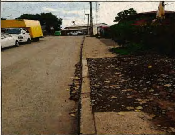
Foto N°21: 10 de mayo de 2018. Soleras instaladas.
