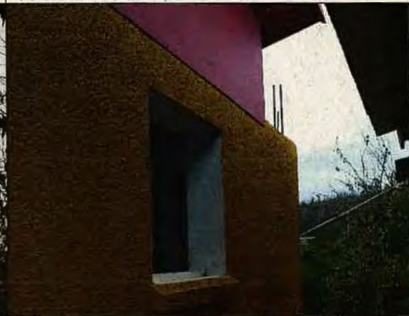
Foto N°24: 16 de mayo de 2018. Muro casetas sanitarias.
