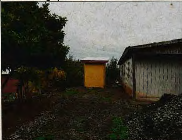
Foto N°45: 16 de mayo de 2018 Casetas sanitarias construidas.
