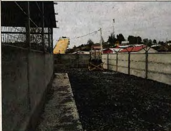
Foto N°15: 16 de mayo de 2018. Planta de tratamiento de aguas servidas.
