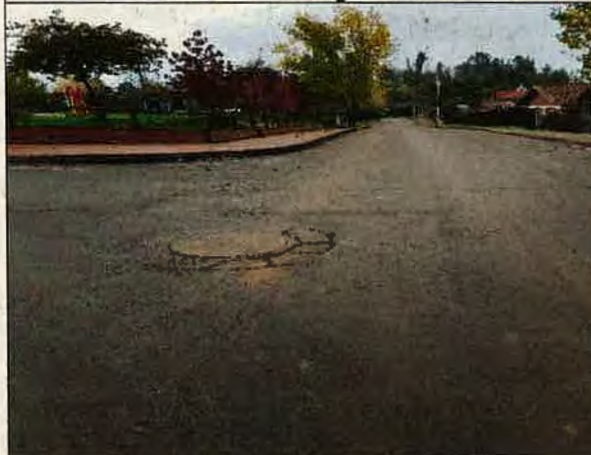
Foto N°17: 17 de mayo de 2018. Cámara de inspección pública.
