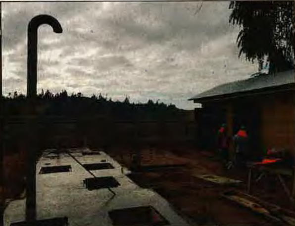
Foto N°2: 10 de mayo de 2018. Recinto de planta elevadora de aguas servidas.
