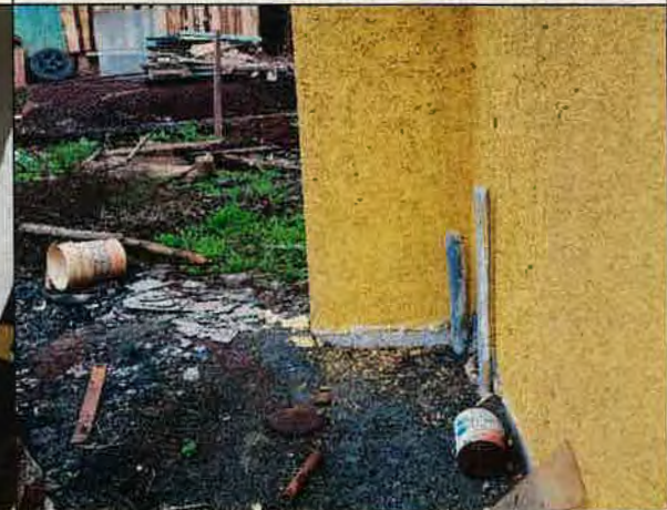
Foto N°12: 16 de mayo de 2018. Sector de lavadero de casetas sanitarias.
