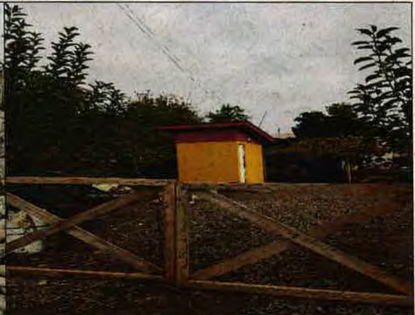
Foto N°44: 10 de mayo de 2018 Casetas sanitarias construidas.
