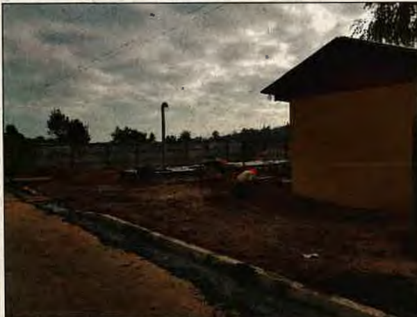
Foto N°1: 10 de mayo de 2018. Recinto de planta elevadora de aguas servidas.
