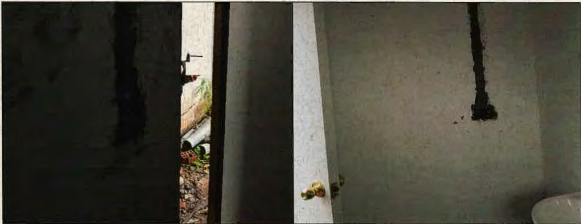
Foto N°31: 16 de mayo de 2018. Interior casetas sanitarias.
