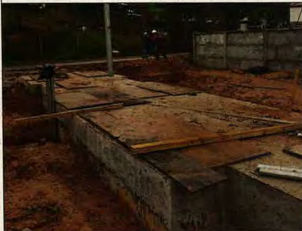
Foto N°3: 16 de mayo de 2018. Recinto de planta elevadora de aguas servidas.
