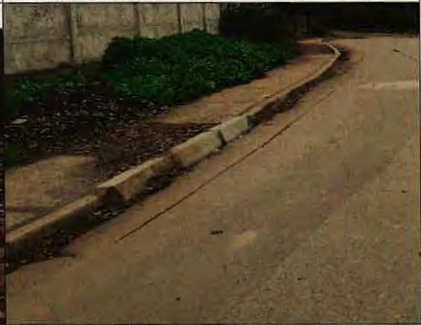
Foto N°22: 10 de mayo de 2018. Soleras instaladas.
