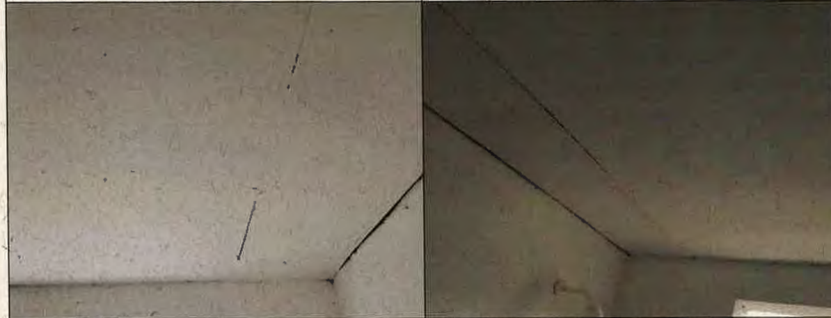
Foto N°27: 16 de mayo de 2018. Interior casetas sanitarias.
