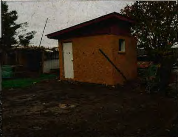
Foto N°46: 16 de mayo de 2018 Casetas sanitarias construidas.
