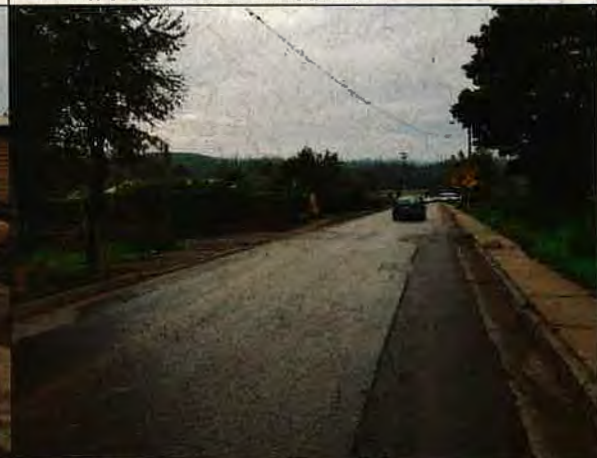
Foto N°48: 16 de mayo de 2018 Corte y reposición de pavimentos.
