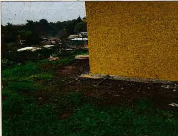
Foto N°13: 16 de mayo de 2018. Exterior casetas sanitarias.
