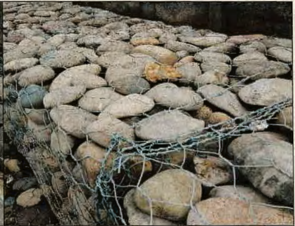
Foto N°20: 10 de mayo de 2018. Gaviones recinto PTAS.
